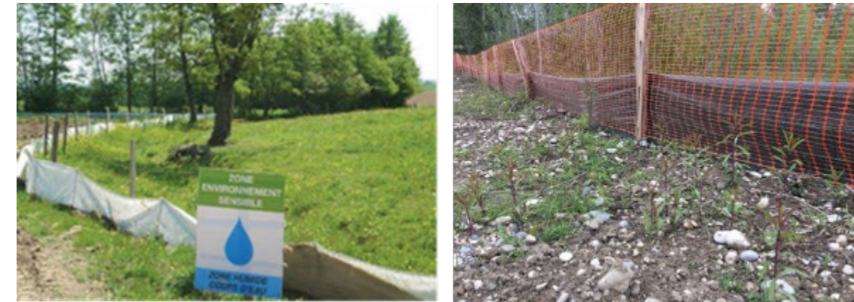
Figure 32 : Signalétique et balisage de milieux naturels (Source : EDF power solutions)
