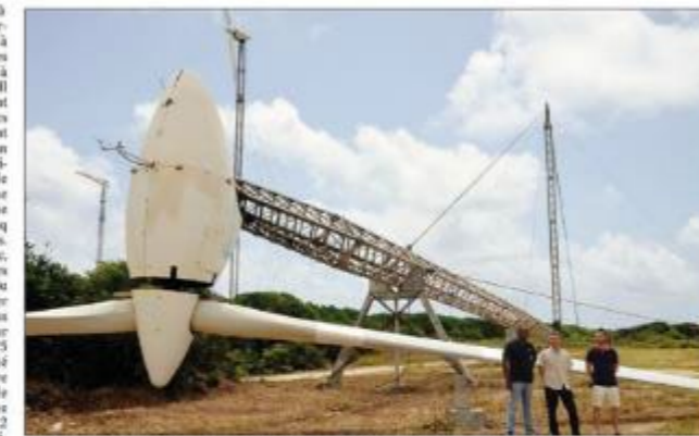
Pour les besoins de la journée portes ouvertes, une éolienne a été abasourdie au sol afin que les visiteurs puissent mieux se rendre compte des technologies qu'elle intègre et des changements qu'elle subira. Les responsables du site étaient à la disposition du public.
