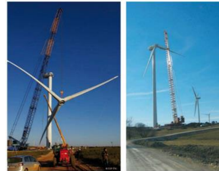
Figure 37 : Montage du rotor (à gauche), montage "pale par pale" (à droite) (Source: EDF power solutions)
