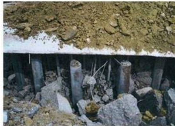
8 - Mise en place et mise à feu des explosifs pour destruction des fondations et évacuation vers les filières adaptées de gestion des déchets
