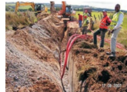
Figure 38 : Déroulage et pose des câbles (Source : EDF power solutions)
