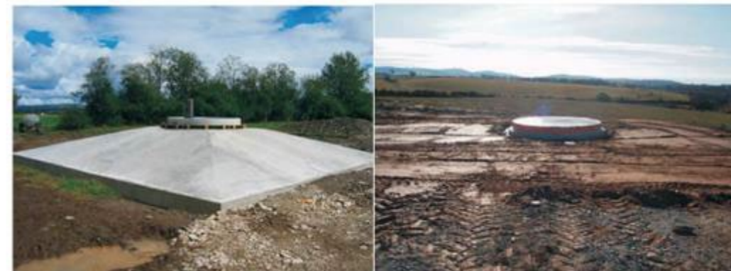
Figure 35 : Massif béton terminé (à gauche), état final après remblaiement (à droite) (Source : EDF power solutions)
