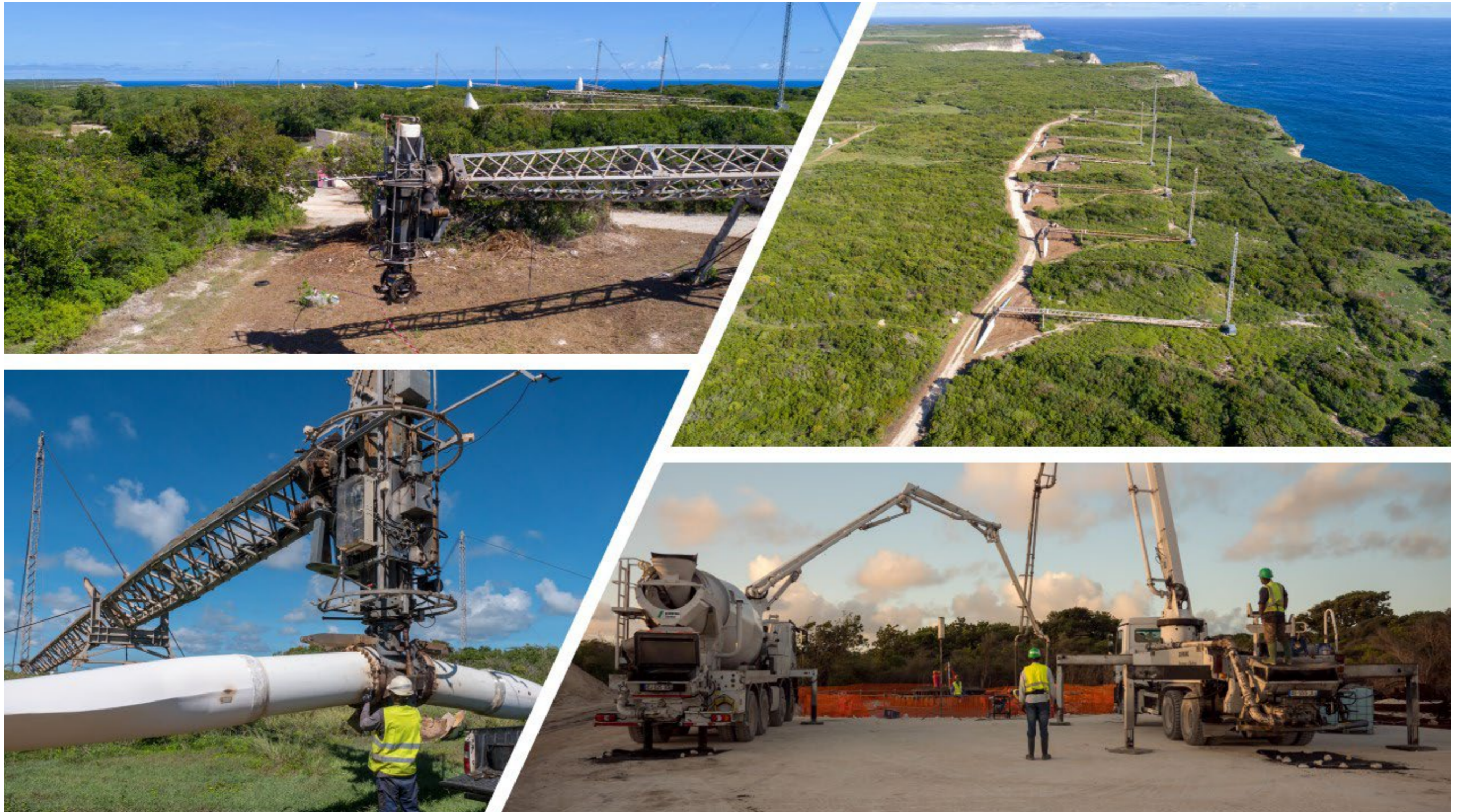
Figure 41. Démantèlement du parc éolien de Petit Canal
