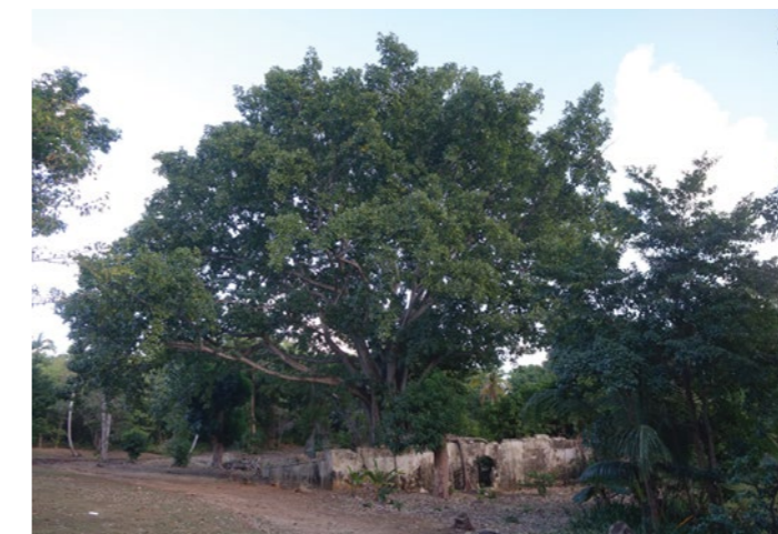
Les anciennes prisons (monument inscrit) situées au niveau du bourg de Petit-Canal
