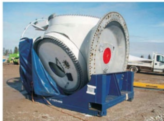
Stockage d'un rotor sur une plateforme (EDF Renouvelables)
